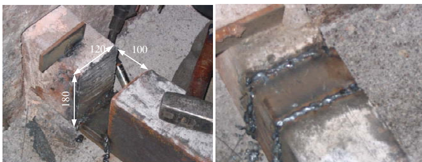
Slika 12: Priprema stranica i zavareni spoj provodnika primjenom ručnog GMAW postupka – Kombinat aluminijuma Podgorica
