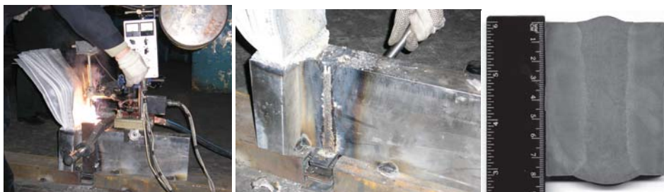
Slika 11: Izvođenje elektro-lučnog CGEAW zavarivanja provodnika u elektrolitičkim ćelijama (80x220 mm)
