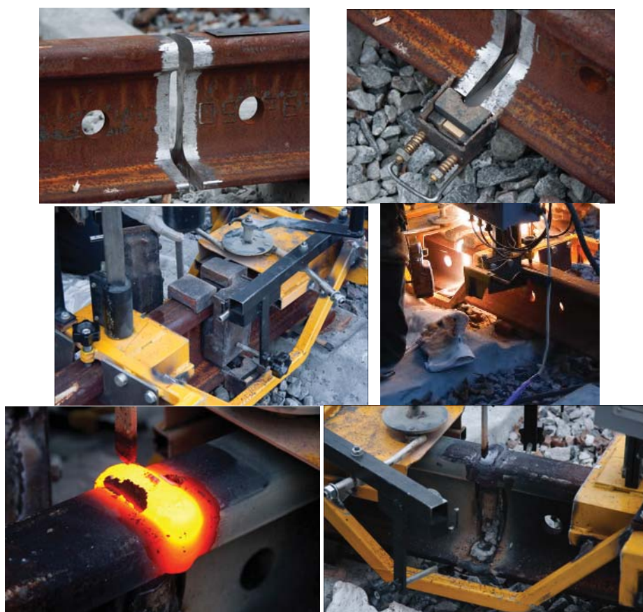
Slika 10: Radni koraci pri CGEAW postupku zavarivanja šina
